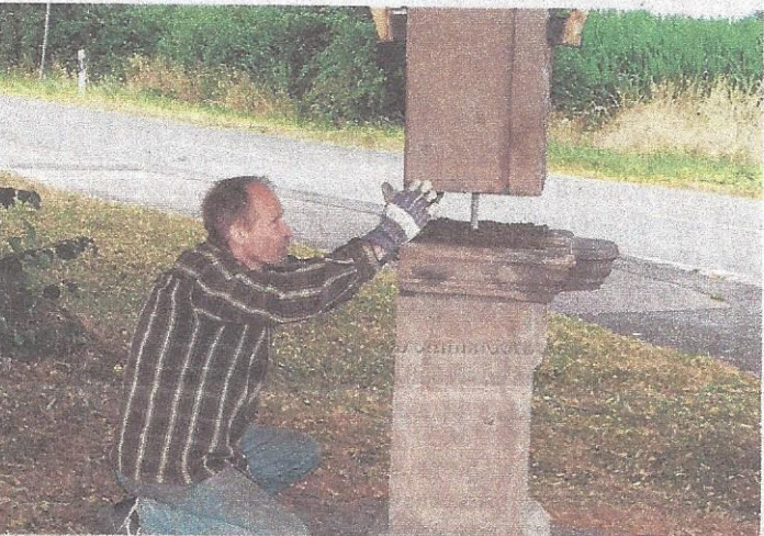
Jörg Stowasser justiert das Bauteil beim Absenken auf den Sockel.
