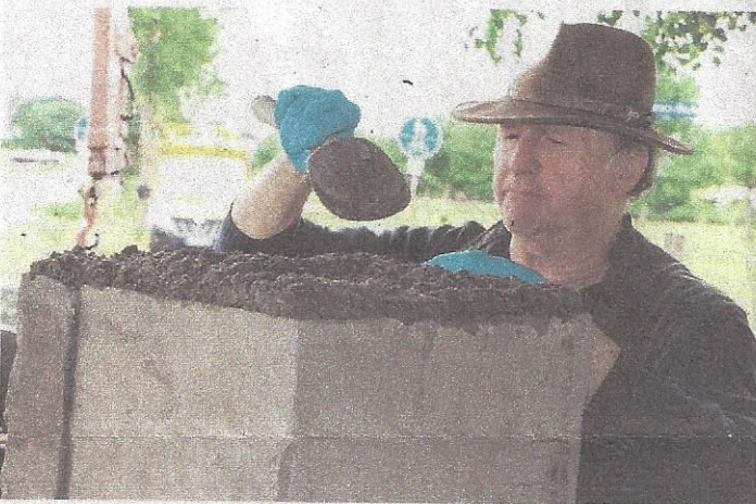
Rainer Pape trägt eine Schicht Zement auf, die als Verbindung wirkt.
